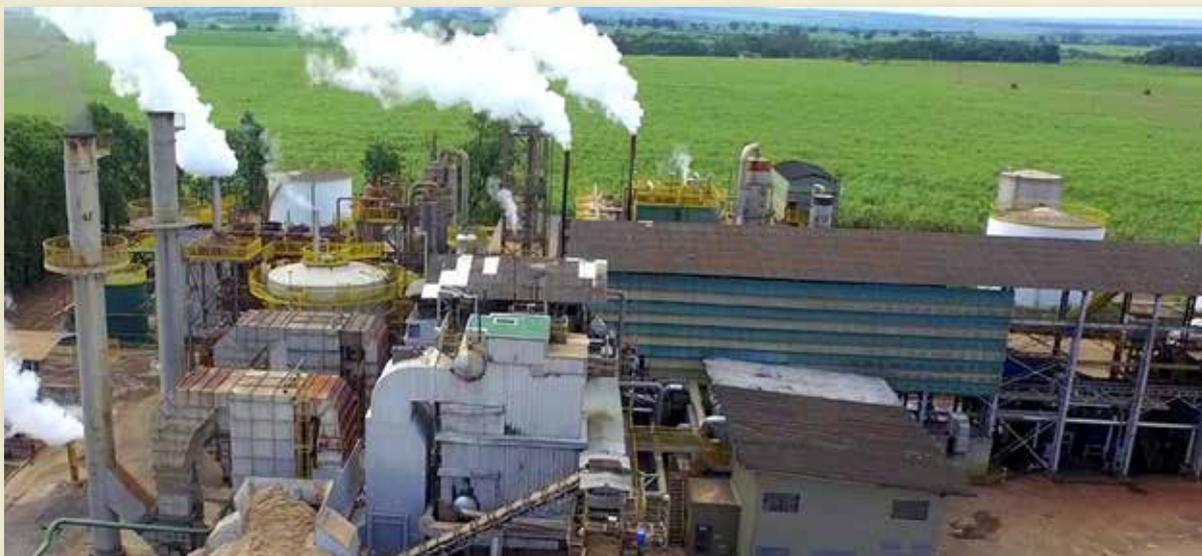
A Companhia Müller de Bebidas utiliza a queima de biomassa (bagaço) para a cogeração de energia elétrica (99,2% da demanda energética da Unidade Lageado).
